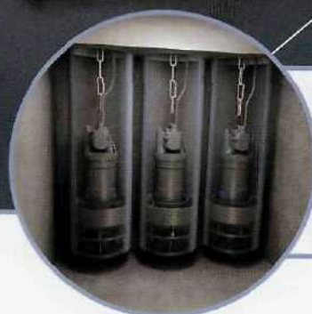
Заборная станция сырой воды
