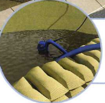
Защита от наводнений и очистные работы
