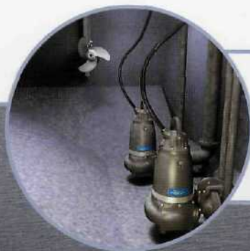
Откачка технологической воды со вторичной окалиной, образующейся при прокатке
